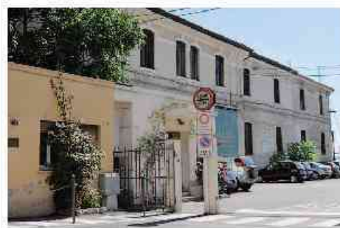
L'ex deposito franco della Salso alla Marina di Porto Maurizio: avviati incontri sul riutilizzo della struttura che confina con il nuovo Museo navale
